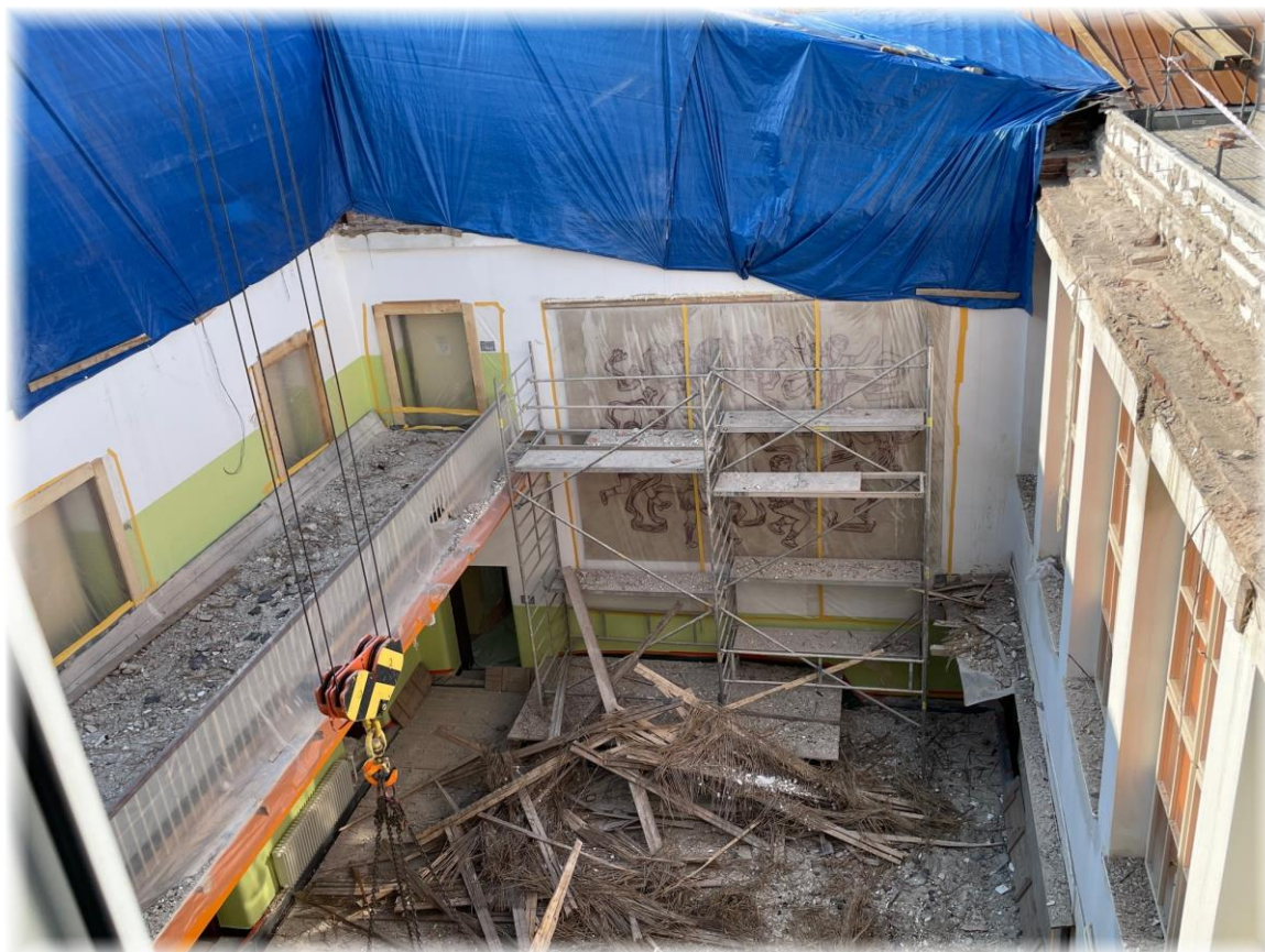
První fáze započaté přístavby školy – stržení stropu v hale a nahrazení nosným.
